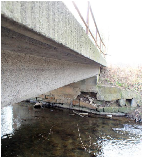
Abb. 31/32: Die Straßenbrücke Cannewitz - Rackel (Bautzen - Baruth) wurde nach der Teilbegradigung des Flussbettes des Kotitzer Wassers neu errichtet. Da die einstige Straße bis zur Autobahn als Wirtschaftsweg herabgestuft wurde, gab man sich beim Bau der Brücke keine große Mühe. So wurde z.B. das westliche Widerlager einfach auf die Grundmauern der alten Brücke aufgesetzt. Aufnahmen: Verfasser März 2014.
