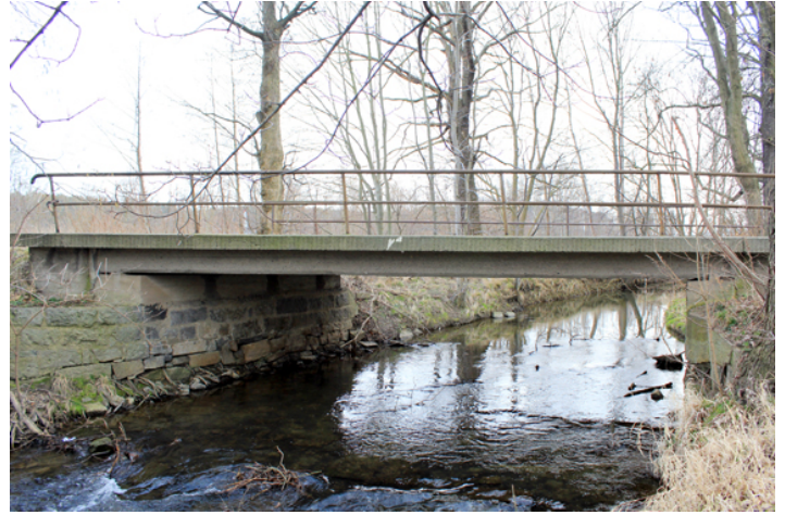
Abb. 31/32: Die Straßenbrücke Cannewitz - Rackel (Bautzen - Baruth) wurde nach der Teilbegradigung des Flussbettes des Kotitzer Wassers neu errichtet. Da die einstige Straße bis zur Autobahn als Wirtschaftsweg herabgestuft wurde, gab man sich beim Bau der Brücke keine große Mühe. So wurde z.B. das westliche Widerlager einfach auf die Grundmauern der alten Brücke aufgesetzt. Aufnahmen: Verfasser März 2014.
