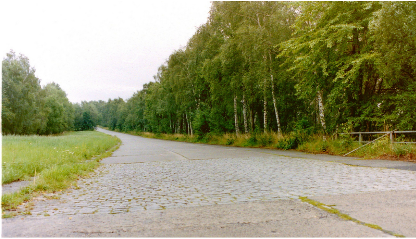
Abb. 06: Die Aufnahme zeigt die Senkenausrundung in der Talsenke im km 73+5 bis km 73+7 hinter der Überführung der Reichsbahnstrecke Löbau – Radibor. Zwar wurde der Steigungswinkel laut GI – Anweisung mit 1:21 in Richtung Weißenberg eingearbeitet, die Senkenausrundung aber nicht ausgeglichen. Dies hätte man durch Aufschütten von Erdreich und der Änderung des gegenläufigen Neigungswinkels des Bauwerkes über die Bahnlinie Radibor – Löbau von 1:20 auf unter 1:21 erreichen können.
