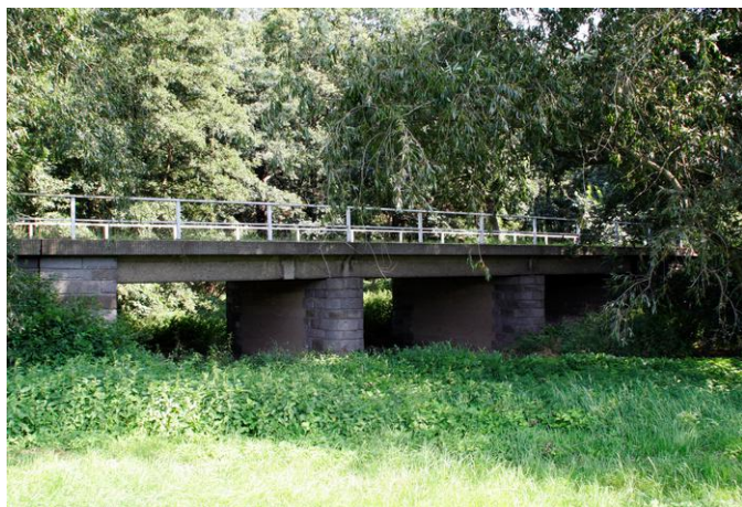
Abb. 10: Der neue Verlauf der Landstraße 2. Ordnung Cannewitz - Rackel wurde auf den Gröditzter Kirchweg gelegt. Dafür wurde Ende 1939 durch die Baruther Firma Martin Graf & Söhne Hoch – Tief, diese Brücke über das Löbauer Wasser gebaut. Aus Kostengründen wurden die Sichtflächen der Mittelpfeiler nicht vollständig mit Naturstein verkleidet. Auffällig ist, dass für die Verkleidung der beiden Widerlager unterschiedlicher Granit verwendet wurde. An der Fahrbahntafel sparte man, da diese nur eine Gesamtbreite von 5 m gegenüber dem Fahrbahnquerschnitt von 7 m aufweist. Nach der Konstruktion ist das Bauwerk eine dreifelder Balkenbrücke, wobei die Balken direkt auf der Auflagebank liegen. Aufnahme: Verfasser, Sommer 2009
