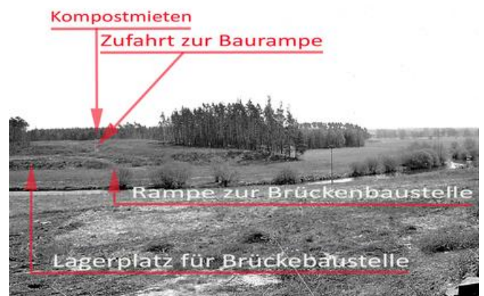
Abb.31 : Blick von Bienitz auf den östlichen Talrand der Queis. Erst nach den Rodungen für die Reaktivierung der ehemaligen Autobahntrasse ist der gesamte Umfang der Erdarbeiten erkennbar. Die Vorarbeiten und das Aufschütten der Fahrbahnböschung bis in das Tal wurden zwischen August 1939 bis Frühjahr 1940 ausgeführt. Die breite Rampe zur Brückenbaustelle wurde für einen Bagger hergerichtet, der bei den Gründungsarbeiten für den östlichen Widerlagerkörper helfen sollte. Aufnahme: Verfasser, Sommer 2006
