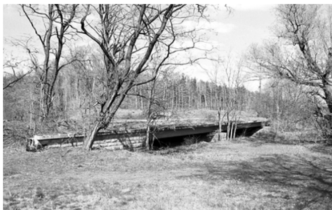
Abb. 19: Flussbrücke „Kleiner Bober“ (BW 13)
