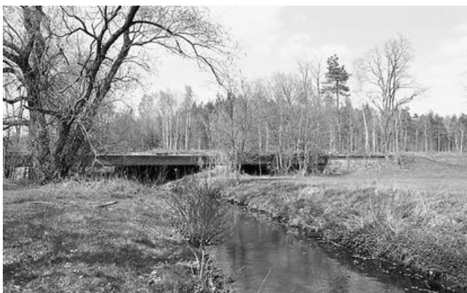
Abb. 18: Flussbrücke „Kleiner Bober“ (BW13)
