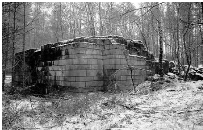
Abb. 36: Südwiderlager der Überführung Landstraße 1. Ordnung Bunzlau - Klitschdorf (BW 21). Die Arbeiten am Bauwerk begannen im Herbst 1940 und mussten witterungsbedingt nach nur kurzer Zeit abgebrochen werden. Ab März 1941 setzt die Firma die Bautätigkeit mit wenigen Kräften fort, um sie im gleichen Monat wegen dem Baustopp wieder abbrechen. Einige Werksteine wurden nach 1945 ausgebrochen. Im hinteren Teil liegen eine Menge grob gebrochene Steine.
