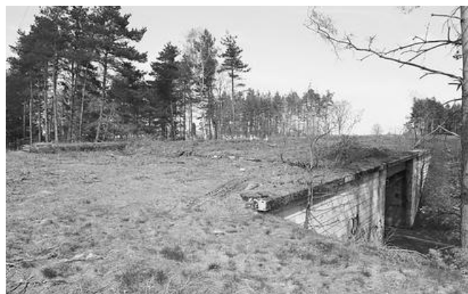
Abb. 17: Fahrbahntafel des Bauwerkes.
