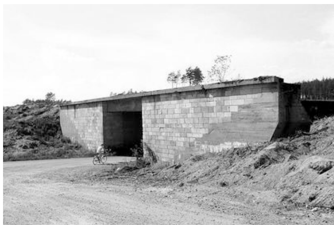
Abb. 21: Wegen dem in das Bobertal eingeschobenem Fahrbahndamm wurde die Ortsverbindung Bunzlau - Kromnitz unterbrochen. Aus diesem Grund erfolgten die Verlegung der Straße und der Bau der Unterführung (BW 25) schon 1939. Aufnahme: Lucjan Zientek, Sommer 2006 https://fortyfikacje.info/
