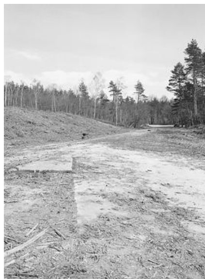
Abb. 48: Ansicht aus Richtung der Auf- und Abfahrtschenkel am unteren Teil. Bautechnisch bedingt ist die Einarbeitung der Fahrbahnneigung bei einer Betonfahrbahn nur stufenartig möglich. Die unterschiedlichen Neigungswinkel und der Kurvenradius erforderten eine genaue Bearbeitung. Dies war hier offenbar so. 2006 ist die Fahrbahn noch tadellos. Was die Ausführung hervorhebt, der Schrambord aus Beton. Diese Gestaltung war nur an Anschlussstellen integrierten Tankstellen innerhalb des Anschlussdreiecks vorgesehen. Der Fahrbahnquerschnitt betrug auf beiden Schenkeln 6 m, was die Standardanforderungen weit übertraf.
