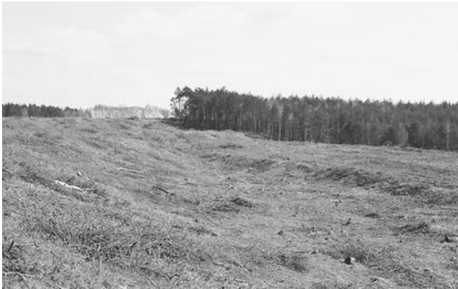
Abb. 49: Nach der Räumung des Areals im Zuge der Reaktivierung 2006, sind die Spuren der Erdarbeiten von 1941/42 zu erkennen. Der stufenartige Absatz zeugt vom Einsatz eines Baggers, mit deren Hilfe das Erdreich für den Aufstieg aus dem Bobertal abgetragen und für den Unterbau der Fahrbahn aufgeschüttet wurde. Da keinerlei Hinweise auf eine Feldbahntrasse in Richtung Moldenberg gefunden wurden, kann davon ausgegangen werden, dass das Erdreich mit Loren und Muskelkraft aufgebracht wurde. Darauf weisen auch die ungleichen Schüttungsspuren an der Böschung hin.
