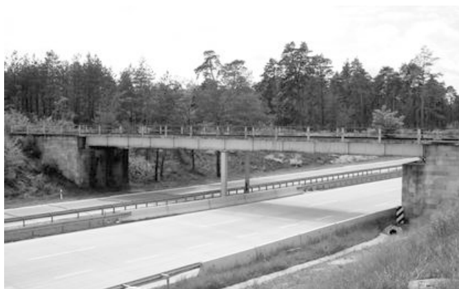
Abb. 38: So hätte die Überführung der Landstraße 1. Ordnung Bunzlau - Klitschdorf nach der Fertigstellung ausgesehen. Die hier abgebildete Bahnüberführung der Strecke Siegersdorf - Sorau an der Berlin - Breslauer Autobahn. Aufnahme: Verfasser, Sommer 2004
