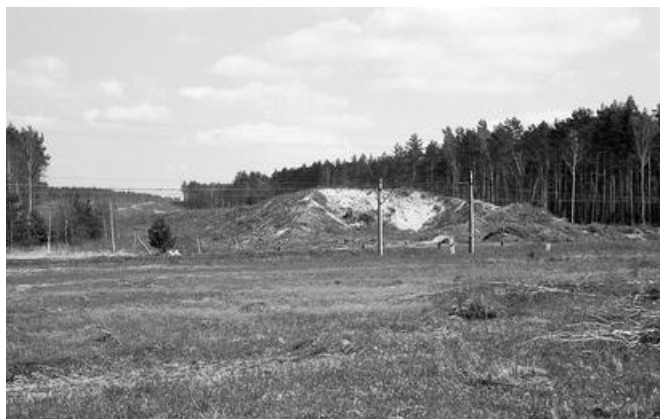
Abb. 22: Blick von Altenhain auf den zwischen Mitte 1940 und Anfang 1941 aufgeschütteten Fahrbahndamm. Im Vordergrund die Bahnstrecke Kohlfurt - Bunzlau. Mit dem Bauwerk für die Bahnüberführung wurde bis zur Einstellung der Bautätigkeit nicht begonnen. Aufnahme: Verfasser, Sommer 2006
