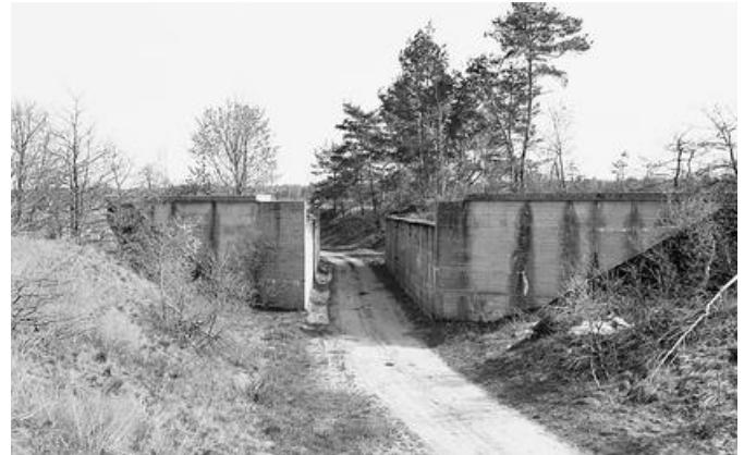
Abb. 41: Im September 1941 wurde mit den zugewiesenen Baustoffen das BW 33 in Höhe Neuendorf Widerlager begonnen. Die Fahrbahnplatte sollte nach der Frostperiode im Frühjahr 1942 gegossen werden.
