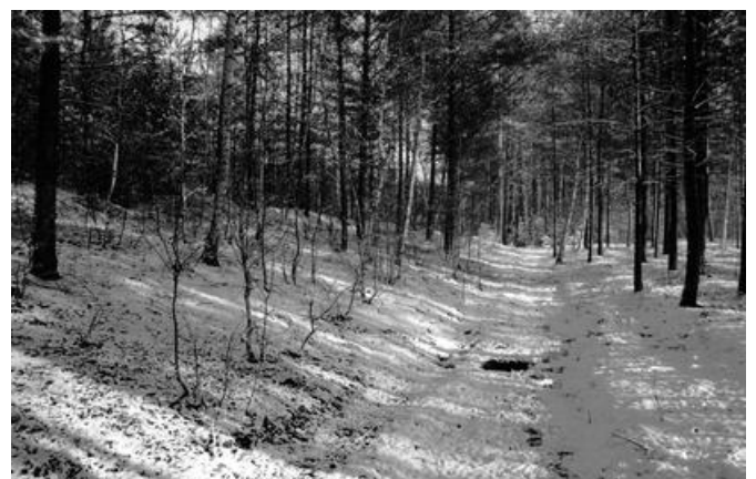
Abb. 33: Im Bild rechts ist die aufgeschüttete Fahrbahnböschung mit dem an der Seite verlaufenden Sickerkanal zu sehen.
