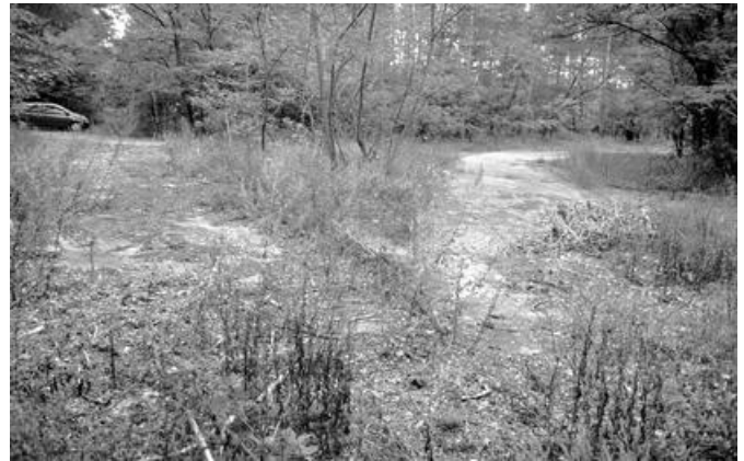
Abb. 52: Anschlussdreieck mit überwachener Park- und Abfahrspur
