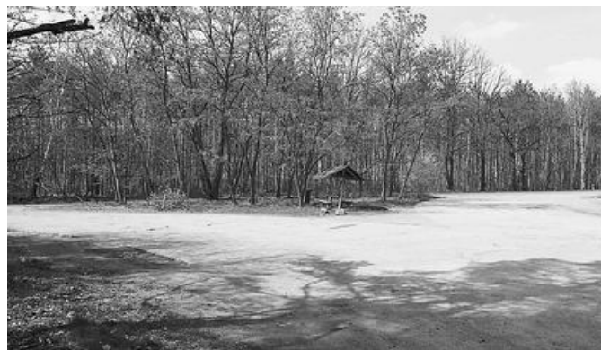
Abb. 46: Die Fahrbahn der sehr großflächig gestaltete Auf- und Abfahrt zum Anschlusschenkel wurde vollständig aus Beton hergestellt. Eine Kennzeichnung der jeweiligen Richtungsspuren war nicht vorhanden. Auf ein Bankett wurde verzichtet.
