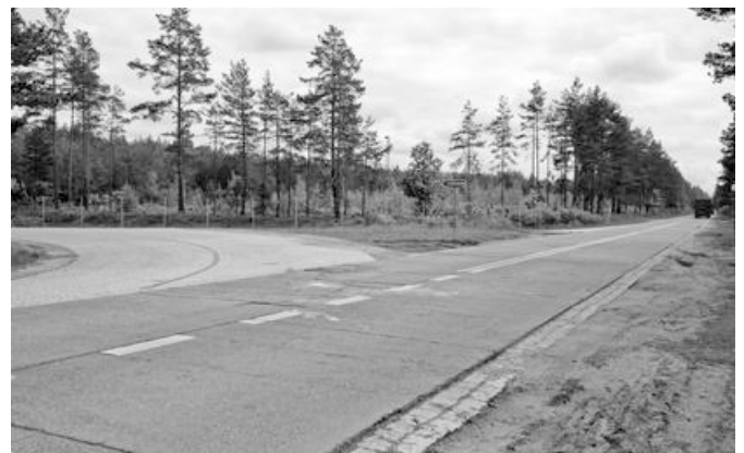
Abb. 58: Südseite der Anschlussstelle Neuhammer, Reichsautobahn Berlin - Breslau mit dem Neubau im Originalzustand. Zur Seitenbefestigung des Neubaus wurden Granitsteinen eingelegt. Das Bankett war lediglich 1 m breit und verdichtet.
