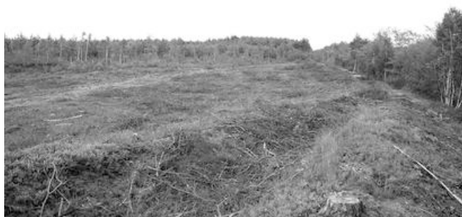
Abb. 25: Nach der Freilegung der ehemaligen Baurasse im Zuge der Reaktivierung sind die Spuren der Vorarbeiten zu erkennen. Rechts im Bild ist der Einschnitt der Bahnlinie Siegersdorf - Sorau zu sehen. Die Böschung wurde zumindest an der Südseite aufgebracht und abgezogen. Aufnahme: Verfasser, Sommer 2006
