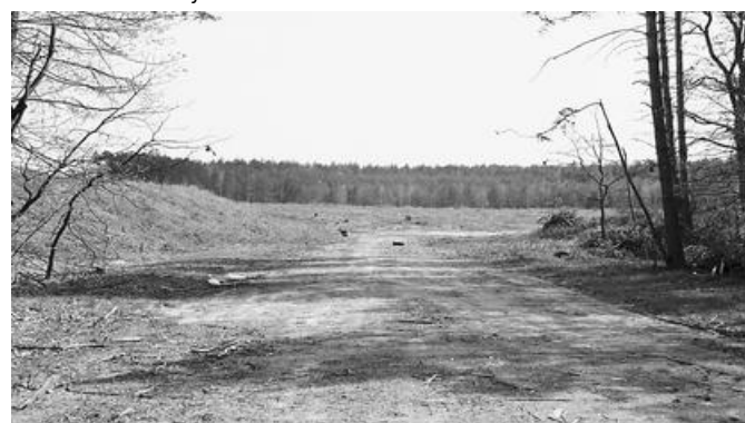
Abb. 47: Die breit ausgeführte Zufahrt ist aus Sicht des Kraftfahrers vorteilhaft und verschafft diesen rechtzeitig einen Überblick über die gesamte Anlage mit dem aus Osten kommen den Verkehr.
