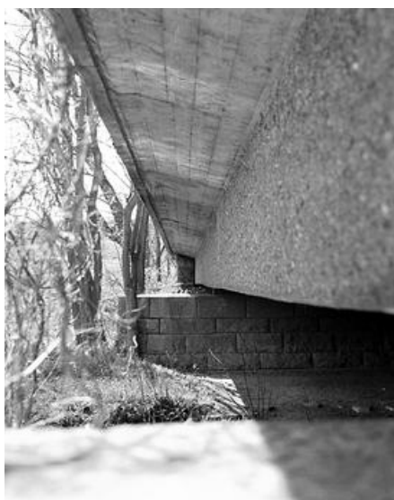
Abb. 20: Detailaufnahme von der unteren Seite der Fahrbahntafel. Die Sichtflächen der Werksteine wurden bossiert. Der Beton am Längsträger wurde mit Stockschatz bearbeitet. Aufnahme: Verfasser, Sommer 2006
