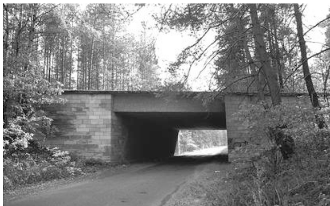
Abb. 16: Überführung der Landstraße 2. Ordnung Nieder Schönfeld - Neundorf (Bw 23)
