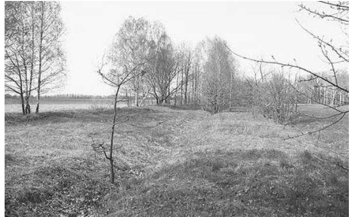
Abb. 13: Westlich der Ortsverbindung Nieder Schönfeld - Eichberg wurde direkt an der ehemaligen Bahnlinie der Bunzlauer Kreisbahn für Materialtransporte für den Reichsautobahnbau ein Hilfsdamm angefügt und das Gelände am Streckengleis auf ca. 300 m erweitert. Die Aufnahme entstand in westlicher Richtung unmittelbar an der Bautrasse der Autobahn. Aufnahme: Verfasser, 2003
